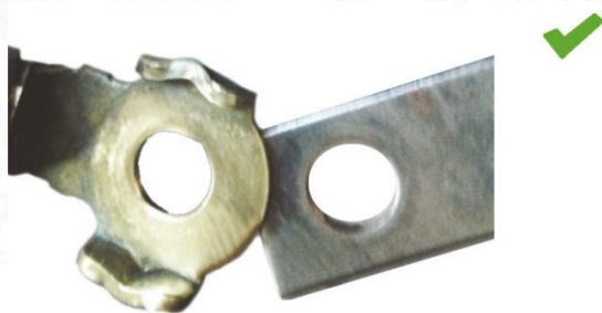
Рис. 2: Подключение заземления после очистки: хороший контакт
